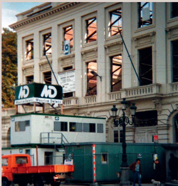
Le chantier de la Cour d'arbitrage en octobre 1991
